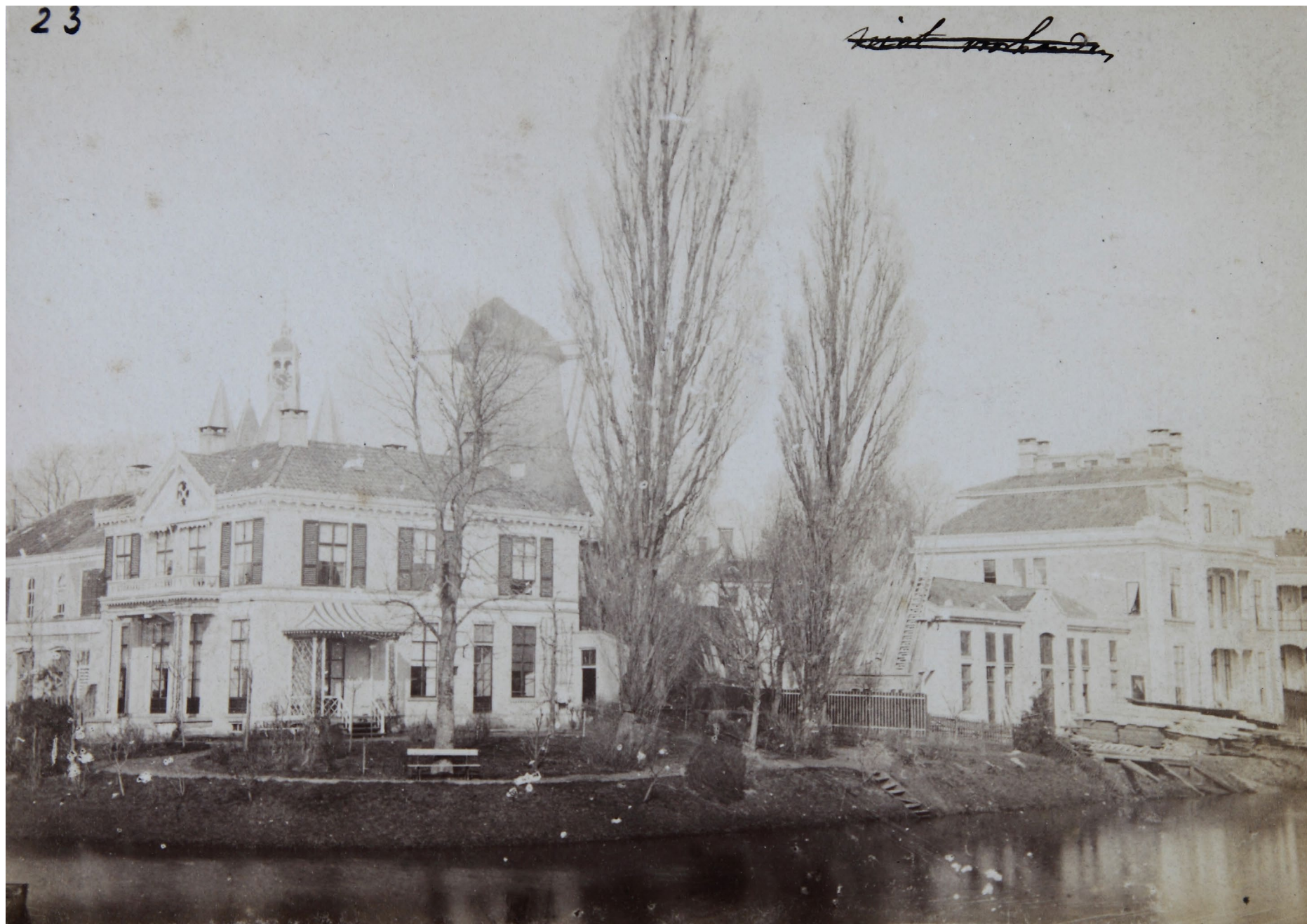
Achterzijde van de huizen aan het Van Nahuysplein gezien vanuit het zuidoosten, met links nummer 8. De foto dateert van vóór 1870 (het jaar dat de molen werd afgebroken) <fotograaf: F.W.H. Deutmann, HCO>
