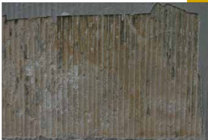
Imitatie natuursteen stucwerk Blijmarkt 20 (Uit kleuronderzoek Bert Jonker).
