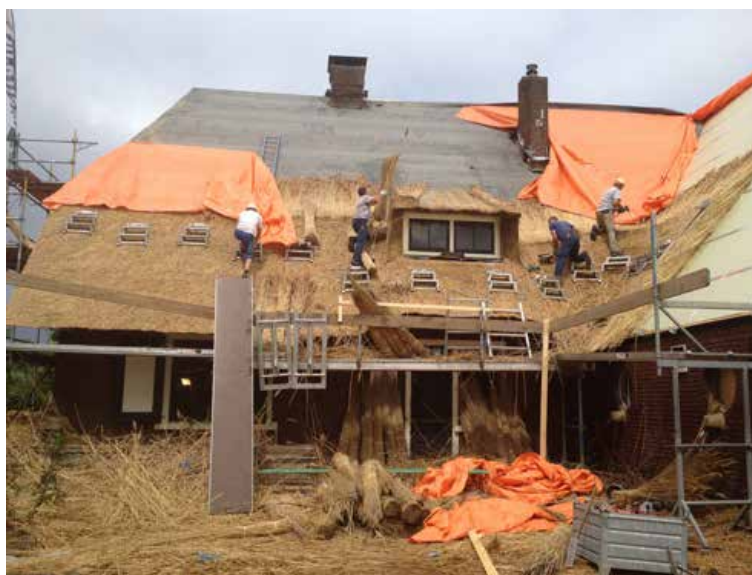
Boerderij de Mars: rietdekkers aan het werk (Bierman Henket architecten).
