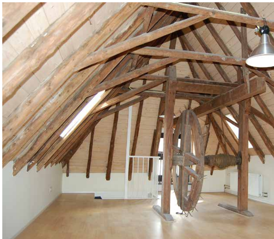
Kromme Jak: Zwolse kap of A spant met hijssrad (ARCX).
