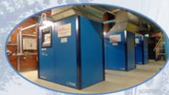
Nieuwe compressoren (gerealiseerd)
